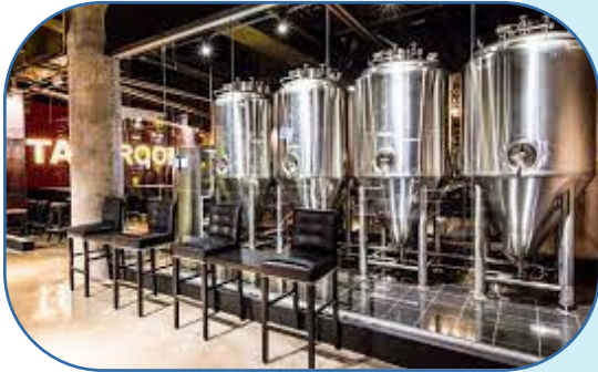
BARRILES DE FERMENTACIÓN, UNA FUENTE DE AGUAS RESIDUALES
