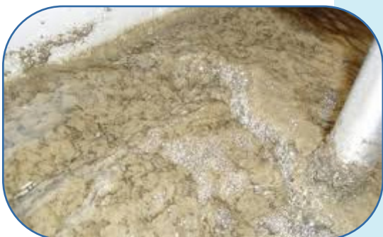
LOS SÓLIDOS COAGULADOS FLOTAN SOBRE LAS AGUAS RESIDUALES
