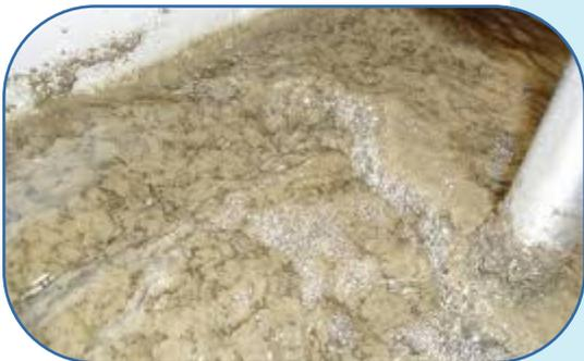
**КОАГУЛИРОВАННЫЕ ТВЕРДЫЕ ВЕЩЕСТВА ВСПЛЫВАЮТ НА ПОВЕРХНОСТЬ СТОЧНЫХ ВОД**
