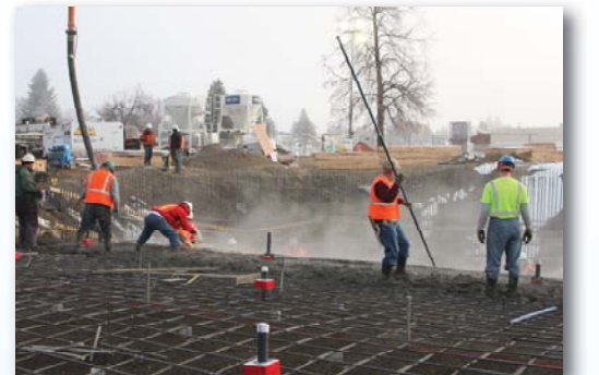
Crews pour cement for the new pool bottom at Shadle.
